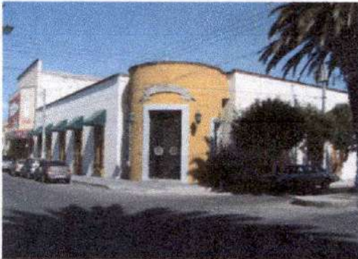
Ilustración 2. Fachada principal de la Libertad Centro Cultural, Apizaco (Sistema de Información Cultural, 2018.).
