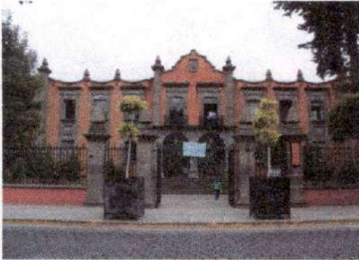
Ilustración 1. Fachada principal del Centro Cultural Tlaxcala (El Porvenir, 2017).
