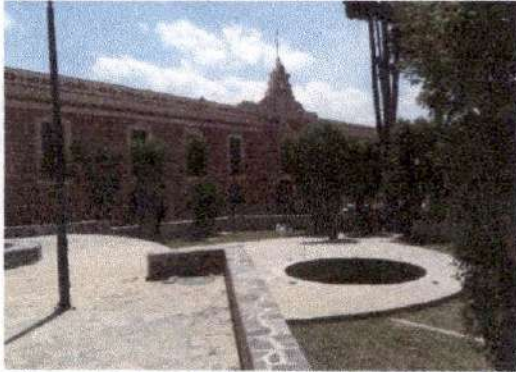
Ilustración 3. Fachada del Centro de las Artes, Tlaxcala (ITC, 2016).
